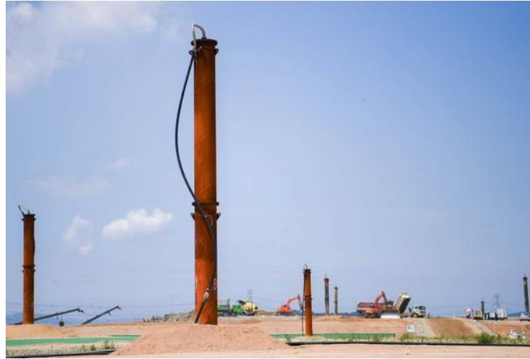
사진 출처: 환경일보 (기사), 수도권매립지 제3매립장 가스 포집시설 설치
